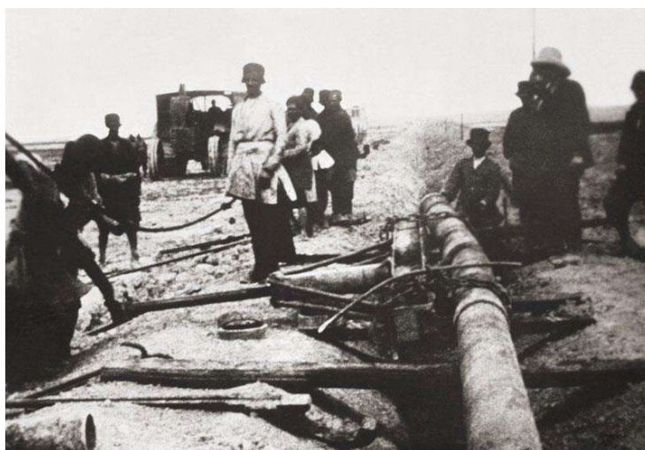
احداث خط لوله نفت بوسیله ی دستگاه جوش الکتریکی - سال ۱۲۹۵ خورشیدی ( ۱۹۱۶ میلادی )
